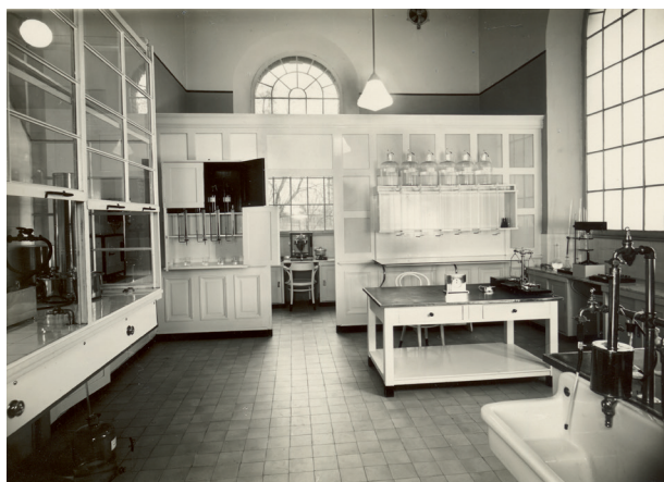
Wnętrze chlorowni w wodociągach krakowskich na Bielanych, 1933, fot. Stanisław Mucha, nr inw. MHK-Fs19586/IX
