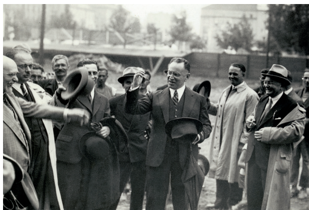
Mieczysław Kaplicki na placu budowy Muzeum Narodowego, 1934, fot. Agencja Fotograficzna Światowid, nr inw. MHK-Fs8649/IX
