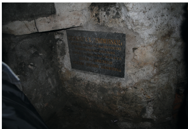
Ryc. 8. Krypta kaplicy Lubomirskich – relikw kamiennego muru kolistej wieży po zachodniej stronie wejścia do krypty, fot. M. Goras
