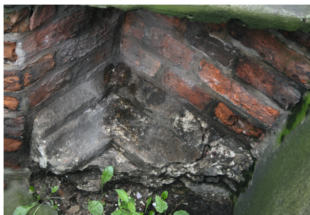
Ryc. 12. Relikt przypory kaplicy Pileckich pod południowo-zachodnim narożnikiem kaplicy Lubomirskich (czytelny w kanale osuszającym), fot. H. Rojkowska
