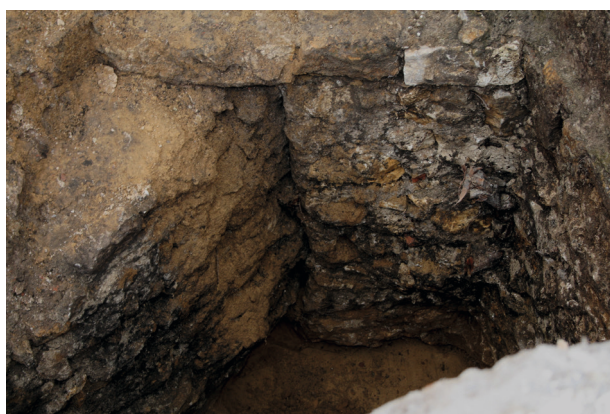
Ryc. 14. Południowa część wykopu – cezura dostawienia fundamentu kaplicy Pileckich do fundamentu kolistej wieży (z lewej) oraz związany narożnik środkowej przypory i ściany kaplicy (z prawej), fot. H. Rojkowska
