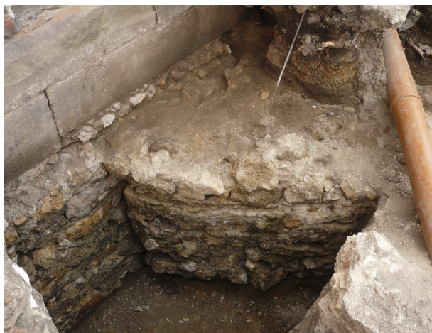
Ryc. 2. Północna część wykopu – styk najstarszego muru z dostawioną kolistą wieżą, na koronie obydwóch murów wtórna warstwa wyrównawcza zalana zaprawą, pod cokołem warstwa kamieni wyrównująca ciosy, fot. W. Niewalda
