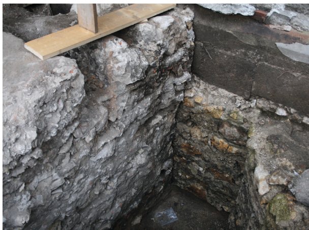
Ryc. 3. Północna część wykopu – z lewej mur kaplicy Przemienienia Pańskiego z końca XVI w., dostawiony do najstarszego muru i cokołu halowego korpusu, z prawej fragment kolistej wieży, fot. W. Niewalda
