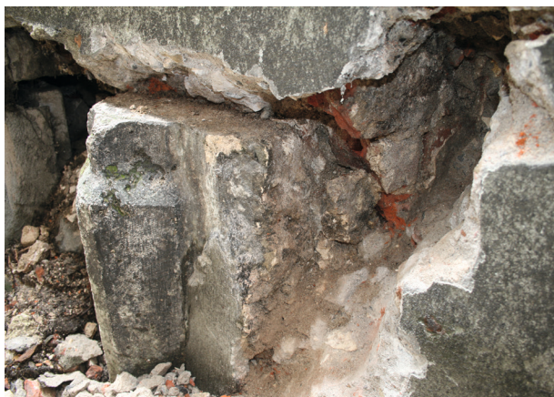
Ryc. 16. Kanał osuszający – relikw kamiennej służki i południowego gładu wejścia ze śladami tynkowej wyprawy, fot. H. Rojkowska
