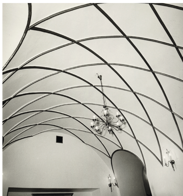
Fragment sklepienia kawiarni Europejska, ok. 1987, fot. A. Wierzbicki; w zbiorach MHK, nr inw. MHK-Fs 18596/IX/1
