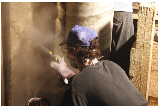
Ryc. 8. Czyszczenie parownicą zabrudzeń muru. Widok w trakcie konserwacji, fot. M. Sawicki
