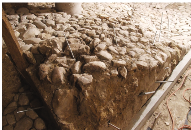
Ryc. 14. Wzmacnianie metalowych rurek ocynkowanymi metalowymi prętami. Widok w trakcie konserwacji, fot. P. Podolski
