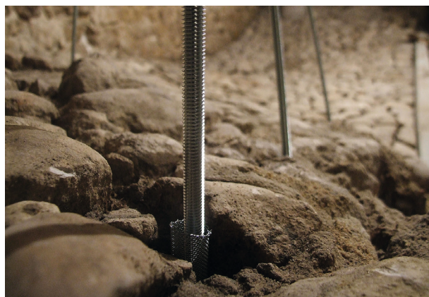
Ryc. 13. Wzmacnianie metalowych rurek ocynkowanymi metalowymi prętami. Widok w trakcie konserwacji, fot. P. Podolski
