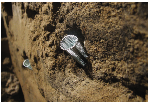
Ryc. 12. Założone rurki z siatek do mikropalowania. Widok w trakcie konserwacji, fot. P. Podolski
