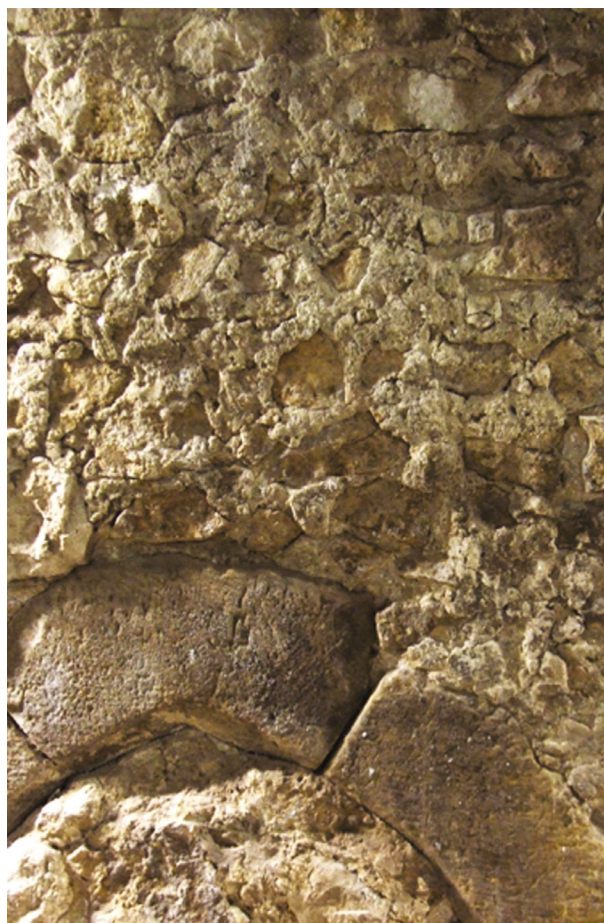
Ryc. 9. Fragmentarycznie zachowane pozostałości zapraw spoinujących i licujących, w kilku miejscach zrekonstruowane. Widok po konserwacji, fot. P. Podolski
