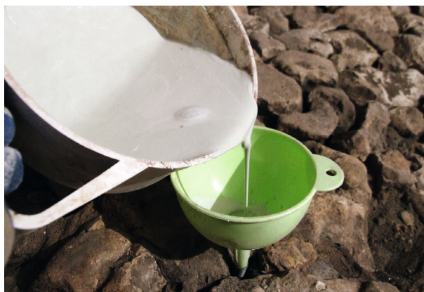
Ryc. 15. Wzmacnianie zezbrojonych metalowych rurek zaczynem cementowym. Widok w trakcie konserwacji, fot. P. Podolski
