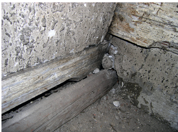
Ryc. 41. Trzecie piętro, pomieszczenie nr 419, narożnik południowo-zachodni. Po prawej fazowana belka przysięenna oparta na murlacie (elementy osadzone in situ). Poniżej murlaty wtórna belka podwieszona sufitu, fot. Ł. Holcer
