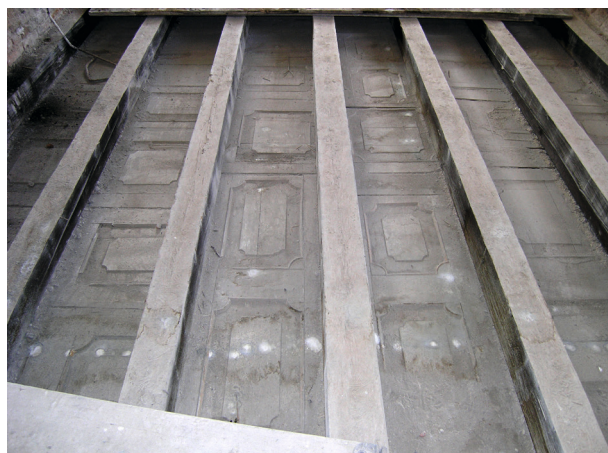
Ryc. 44. Trzecie piętro, pomieszczenie nr 417. Wtórny sufit przytwierdzony do fazowanych belek, wykonany z użyciem profilowanych płycin, fot. Ł. Holcer
