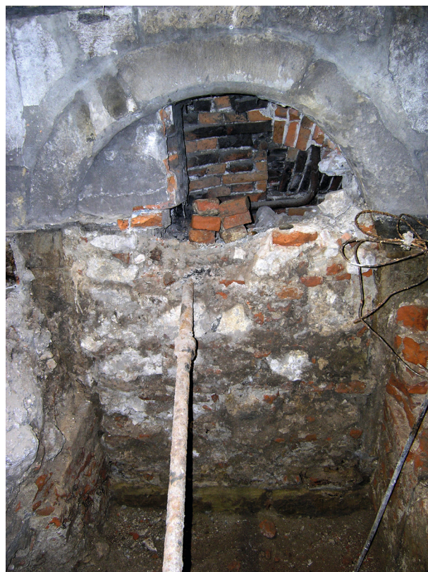
Ryc. 31. Ściana północna, odcinek E, część zachodnia. Zamurowany portal w dawnym zejściu do piwnicy. Po jego bokach pozostałości ceglanych murów oporowych, fot. E. Holcer
