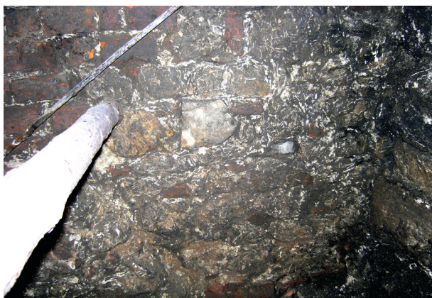
Ryc. 33. Ściana północna, odcinek F, część zachodnia. Staranny wążek z kamienia łamanego oraz fragment z cegły gotyckiej. Oba materiały jednoodrodnie powiązane. Po prawej kamienny, dostawiony fundament pod przyporą zachodnią, fot. Ł. Holcer
