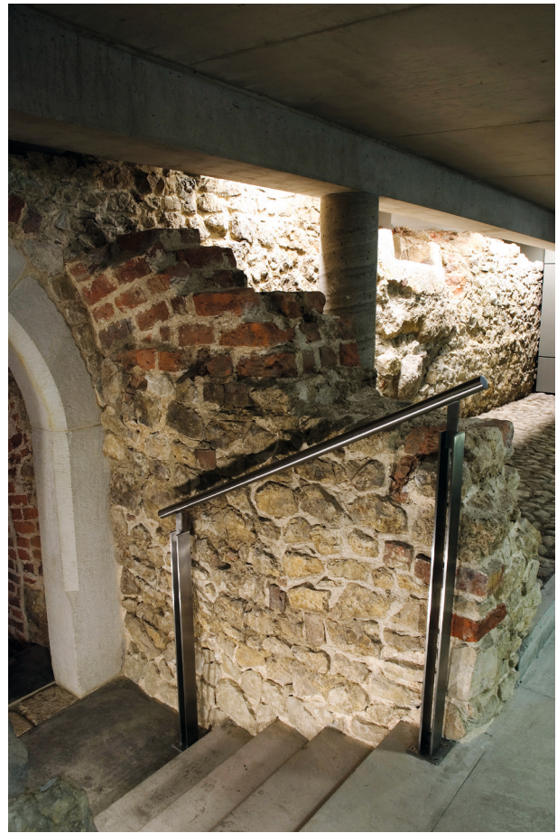
Ryc. 8. Kamienny mur oporowy dostawiony do przedproży przy zejściu do komory północnej. Na jego koronie zachowany fragment ceglano-ukośnie posadowionego sklepienia kolebkowego. Stan po konserwacji, fot. D. Bodzioch
