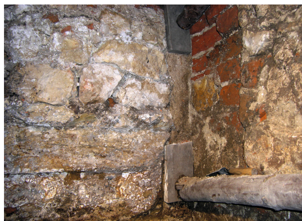
Ryc. 37. Ściana północna, odcinek H, część wschodnia. Fragment zamurowanego zejścia do piwnicy, a w nim zachowana kamienniarka portalu. Po prawej węgar i ościeże opracowane w cegle gotyckiej. Do ceglano-ocścieża dostawiona dolna, kamienna partia zachodniego muru oporowego, fot. E. Holcer
