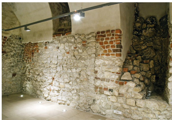
Ryc. 2. Narożna piwnica domu frontowego, ściana północna. Na osi ściany dużej, częściowo zamurowany otwór przejścia na ulicę Szczepańską. W nim pozostałości ostrołukowego portalu z piaskowca. W ścianach przy zachodnim narożniku relikty po osadzeniu ceglanej kapy piecowej, sprzed budowy sklepienia. Stan po konserwacji, fot. D. Bodzioch
