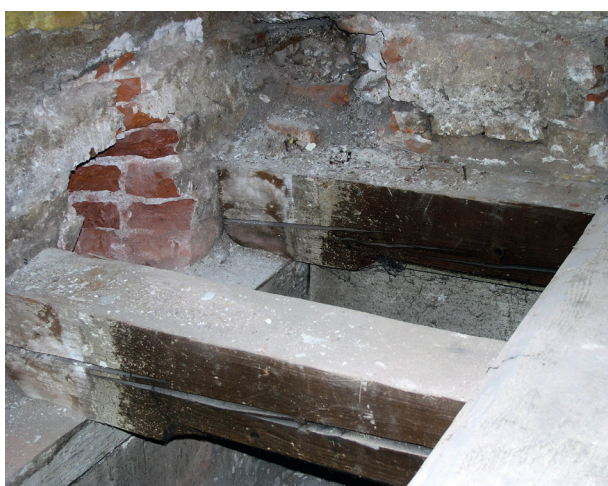
Ryc. 42. Drugie piętro, pomieszczenie nr 320. Fragment stropu przy narożniku południowo-zachodnim. Fazowane belki oparte na murlacie. Na bokach belek ślady po zdemontowaniu drewnianych czółek, fot. Ł. Holcer
