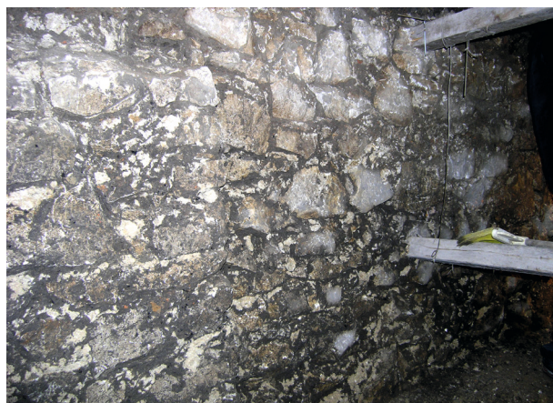
Ryc. 35. Ściana północna, odcinek G, część środkowa. Regularny wążek z dobieranego, warstwowo kładzionego kamienia łamanego, na głębokości 2–3 m poniżej poziomu chodnika, fot. Ł. Holcer
