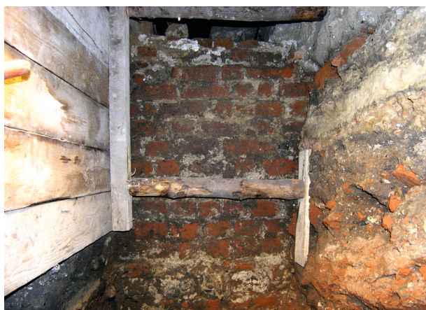
Ryc. 36. Ściana północna, odcinek H. Zachodni mur oporowy przy dawnym zejściu do piwnicy, wzniesiony z gotyckiej cegły palcowanej i kamienia łamanego. Po prawej, pod wtórnym oplaszczowaniem, liczne warstwy nasypów, fot. E. Holcer
