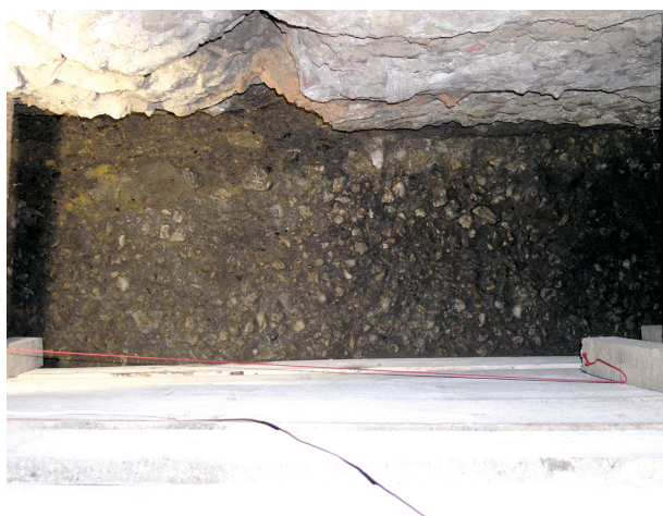
Ryc. 28. Ściana północna, odcinek E. Najniższa, utwardzona warstwa użytkowa złożona z drobnego kamienia na wysokości 208,40 m n.p.m. Przy górnej krawędzi ujęcia oplaszczowanie ściany północnej. Ujęcie od góry, fot. E. Holcer
