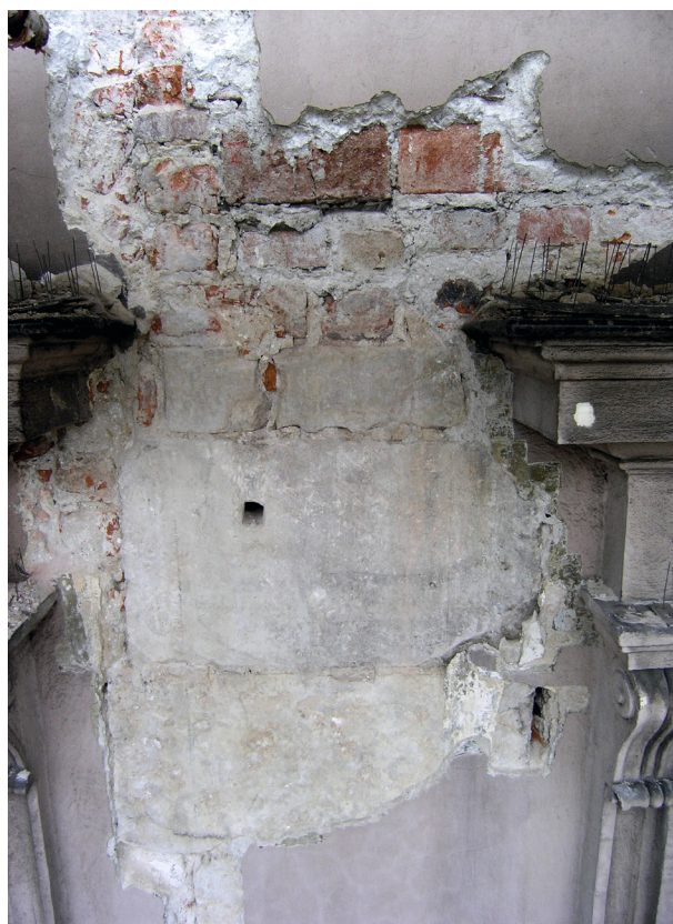
Ryc. 12. Fasada, pierwsze piętro. Górna część kamiennego filara międzyokiennego. Nad nim dwie warstwy cegieł gotyckich z opracowaną na płasko spoiną, fot. Ł. Holcer
