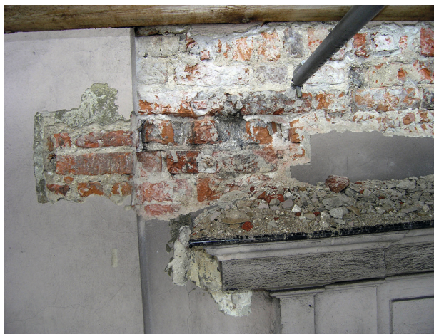
Ryc. 10. Fasada, pierwsze piętro. Fragment najstarszej ściany z fryzem kładzionym rębem skośnym, nad pierwszym oknem od południa. We fryzie zachowany tynk z pobiałami. Wyżej dwie warstwy cegieł w gotyckim układzie wątku i tzw. rolka, fot. L. Holcer
