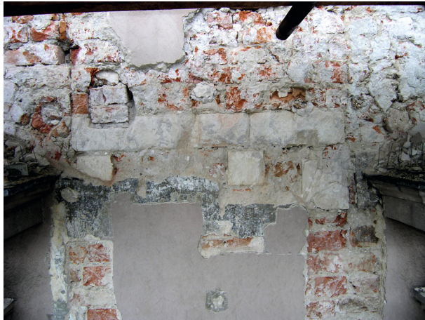
Ryc. 14. Fasada, pierwsze piętro. Pas skutych cegieł między drugim i trzecim oknem od południa, wydzielony pionowymi cezurami, fot. Ł. Holcer
