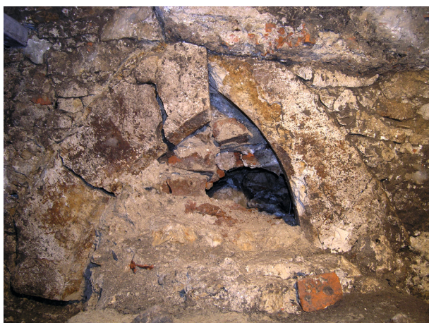
Ryc. 34. Ściana północna, odcinek G, część środkowa. Fragment kamieniarki ostrolukowego portalu z wapienia jurajskiego. Elementy mocno zniszczone, przesunięte względem siebie, ale osadzone in situ, fot. Ł. Holcer
