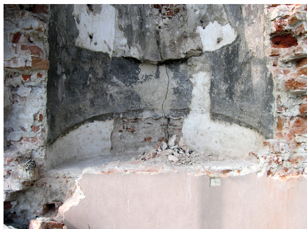
Ryc. 23. Fasada, drugie piętro, wnęka między drugim i trzecim oknem od północy. Powyżej dna konchy odcisk po usuniętej podstawie z ukośnym spadkiem, fot. Ł. Holcer
