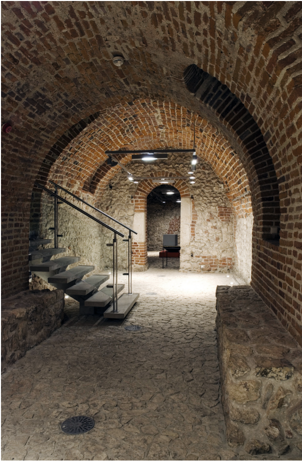
Ryc. 7. Północna komora przedproża. W głębi wtórne przejście do komory południowej, wykute po przesklepieniu obu piwnic. Stan po konserwacji, fot. D. Bodzioch
