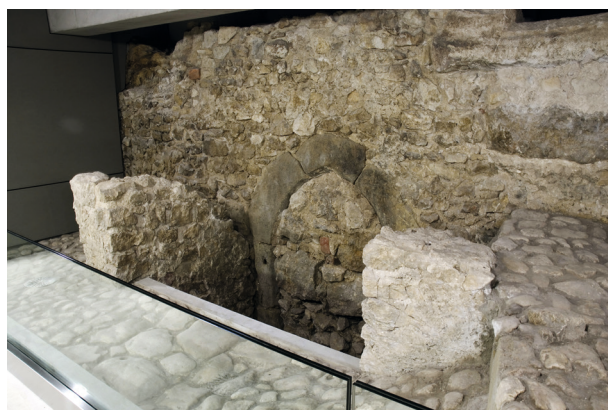
Ryc. 5. Zamurowany portal z piaskowca w zejściu do południowej komory przedproża. Po bokach dostawione kamienne mury oporowe. W górnej partii muru pozostałości po kamieniarce okien. O dołu warstwy starych bruków. Stan po konserwacji, fot. D. Bodzioch
