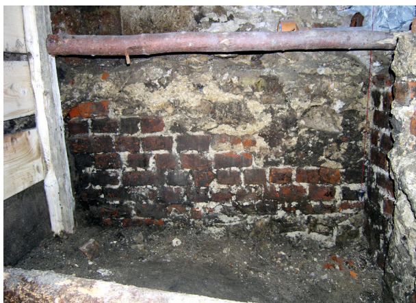
Ryc. 32. Ściana północna, odcinek F. Fragment fundamentu pod przyporą wschodnią. Poniżej kamienia łamanego ściana z gotyckiej cegły palcowanej – zapewne mur oporowy przy dawnym zejściu do piwnicy. Cegła gotycka również w północnej ścianie budynku (po prawej), fot. Ł. Holcer
