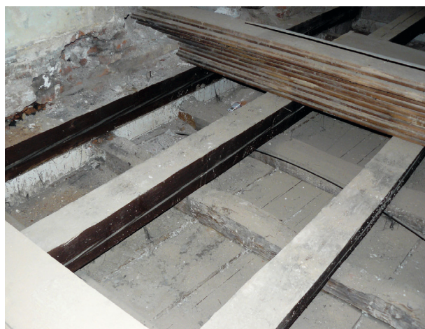
Ryc. 43. Drugie piętro, pomieszczenie nr 318. Fragment stropu z fazowanymi belkami wzdłuż ściany zachodniej. U dołu wtórna konstrukcja podwieszona sufitu, fot. Ł. Holcer
