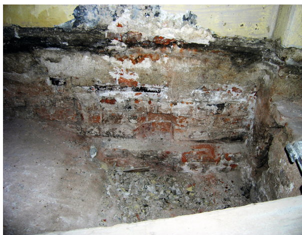
Ryc. 45. Drugie piętro, pomieszczenie nr 314, ściana wschodnia przy południowym narożniku. Poniżej podłogi fragment muru z odsadzką, wzniesionego z grubej cegły palcowanej w gotyckim układzie wątku, fot. Ł. Holcer
