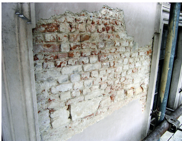
Ryc. 15. Fasada, drugie piętro. Ściana między pierwszym i drugim oknem od południa. Mur w układzie główkowym, z grubej cegły rozbiórkowej, oraz kamienne wtrątki, fot. Ł. Holcer
