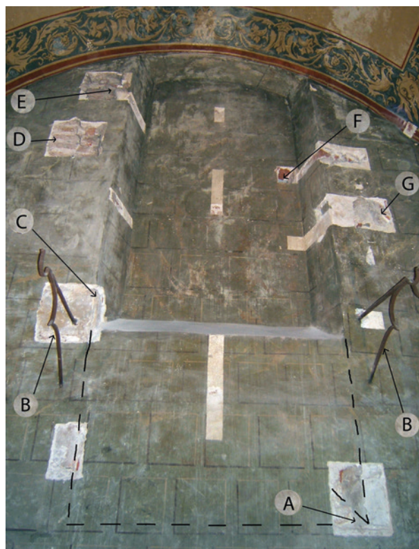
Ryc. 21. Rejon zamurowanego okna gotyckiego kaplicy Grota w zachodniej ścianie zakrystii w trakcie konserwatorskich badań stratygraficznych. Oznaczenia lokalizacji istotniejszych elementów: (A) pierwotny parapet okna, (B) metalowy wspornik, (C) pierwotny kamienny węgar okna, (D) fragment ceglano-wyważania górnych rejonów ściany zachodniej, (E) wążek z podciętymi dekoracyjnie fugami, (F) odkrywka z fragmentem kamieniarki zamurowanego okna, (G) tynk pokrywający powierzchnię absydy i strzypie przypory kaplicy Grota, wprowadzony przed powstaniem zakrystii w obecnej formie. Poniżej wnęki zaznaczony zakres pierwotnej wielkości otworu okiennego, określony w trakcie badań; fot. I. Jakubczyk
