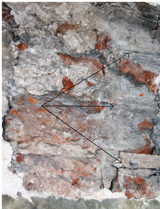
Ryc. 23. Gotycki wątek ceglany ze śladami podciętych pryzmatycznie fug, występujący w zachodniej ścianie zakrystii. Wchodził on pierwotnie w skład górnej części elewacji wschodniej kaplicy Grota; fot. I. Jakubczyk
