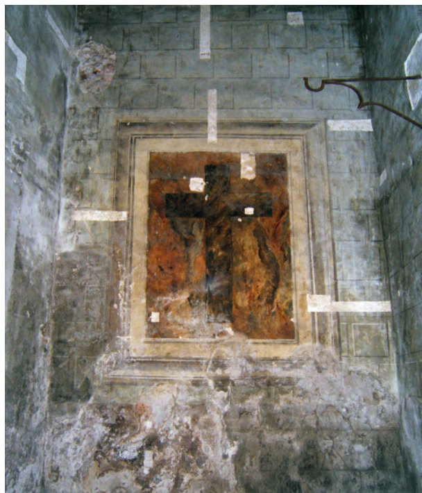
Ryc. 14. Ściana południowa zakrystii z fragmentem dekoracji malarskiej z 1881 r. w formie krzyża w prostokątnej, marmoryzowanej płycinie, w trakcie badań stratygraficznych; fot. I. Jakubczyk
