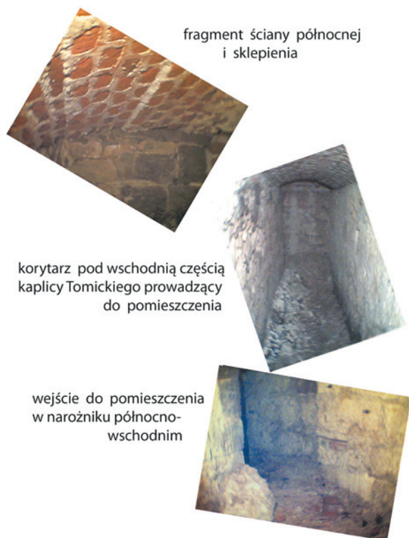
Ryc. 56. Fotografie wykonane w pomieszczeniu pod zakrystią aparatem zabudowanym w kamerze termowizyjnej, ułożone w sposób umożliwiający ogólne rozeznanie formy struktur murowych wnętrza. Widoczny fragment ściany północnej złożonej z ciosów kamiennych, wejście do pomieszczenia oraz korytarz prowadzący do niego pod wschodnią partią kaplicy Tomickiego; fot. W. Nawrocki
