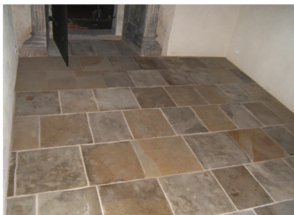
Ryc. 45. Posadzka zakrystii z płyt piaskowca (XVI w.) po konserwacji; fot. I. Jakubczyk
