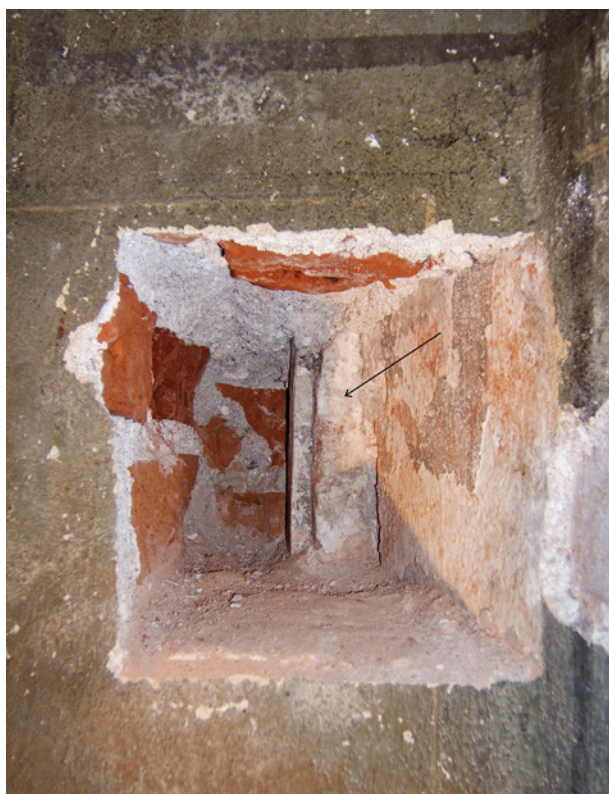
Ryc. 24. Fragment kamieniarki zamurowanego okna gotyckiego kaplicy Grota ujawniony w odkrywce; fot. I. Jakubczyk
