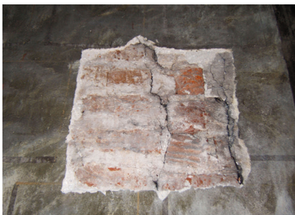
Ryc. 26. Odkrywka z fragmentem ceglano-wątkowym wyrównującym zachodnią ścianę zakrystii w jej górnych partiach; fot. I. Jakubczyk
