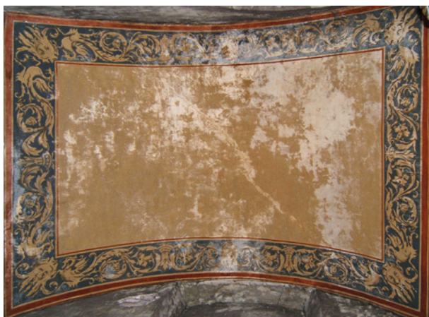
Ryc. 9. Sklepienie zakrystii z dekoracją malarską Erazma Fabijańskiego z 1881 r., stan przed rozpoczęciem badań; fot. I. Jakubczyk
