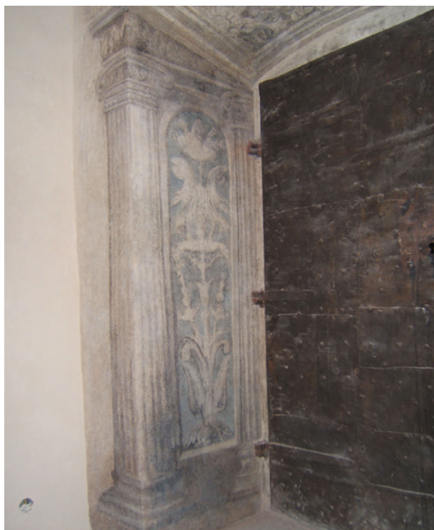
Ryc. 44. Zachodnia płaszczyzna wnęki wejściowej po konserwacji; fot. I. Jakubczyk
