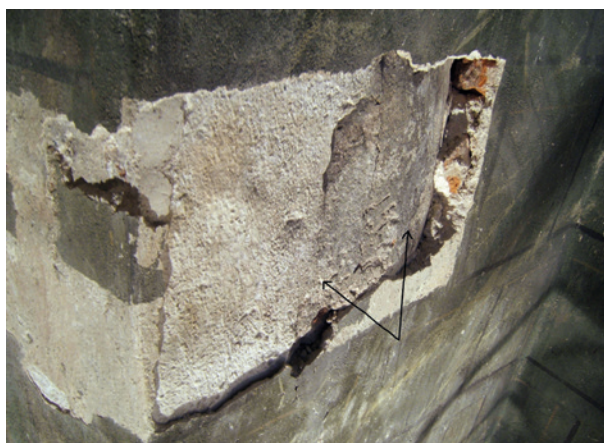
Ryc. 25. Połączony tynku pokrywającego górną część absydy kaplicy Grota (wraz ze strzępiem skutej szkarpy) ujawniona w odkrywce. Widoczna krzywizna elewacji nikażąca pod późniejszym wyrównaniem ściany, wykonanym z udziałem cegły i jej okruców; fot. I. Jakubczyk
