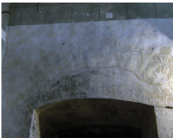
Ryc. 27. Ślady łuku występującego ponad wejściem do zakrystii w formie rytmu charakterystycznych nierówności tynku; fot. I. Jakubczyk
