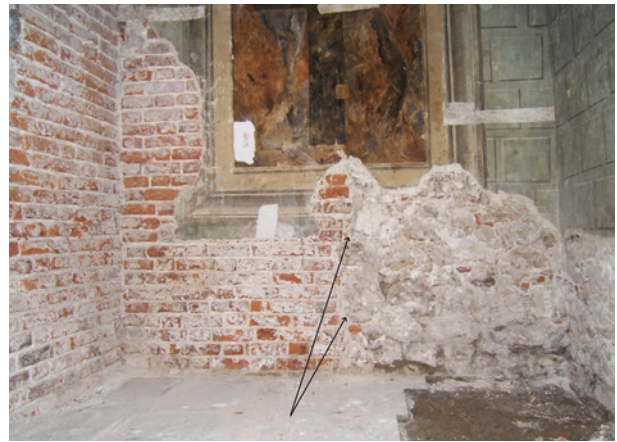
Ryc. 19. Dolna część ściany południowej po usunięciu wtórnych tynków. Widoczna cezura kamiennej i ceglanej partii muru. Powyżej fragmenty dekoracji malarskiej Erazma Fabijańskiego; fot. I. Jakubczyk
