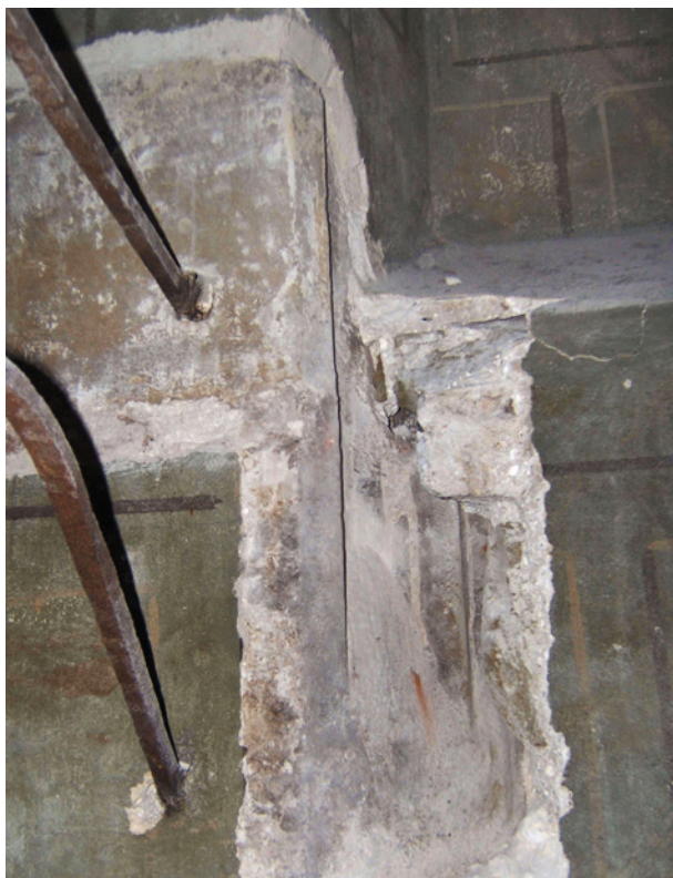
Ryc. 22. Fragment profilowanego węgaru gotyckiego, będącego elementem pierwotnego wystroju kamiennego wschodniego okna kaplicy Grota (ok. połowy XIV w.). Odkryty w trakcie badań poniżej blendy okiennej występującej obecnie w zachodniej ścianie zakrystii; fot. I. Jakubczyk
