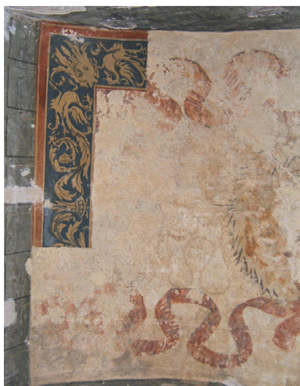
Ryc. 32. Świadek XIX-wiecznej bordiury pozostawiony w trakcie konserwacji w narożniku południowo-wschodnim sklepienia zakrystii. Obecnie zastąpiony warstwami barwionych pobiał wapiennych nawiązujących do kolorystyki dekoracji renesansowej; fot. I. Jakubczyk
