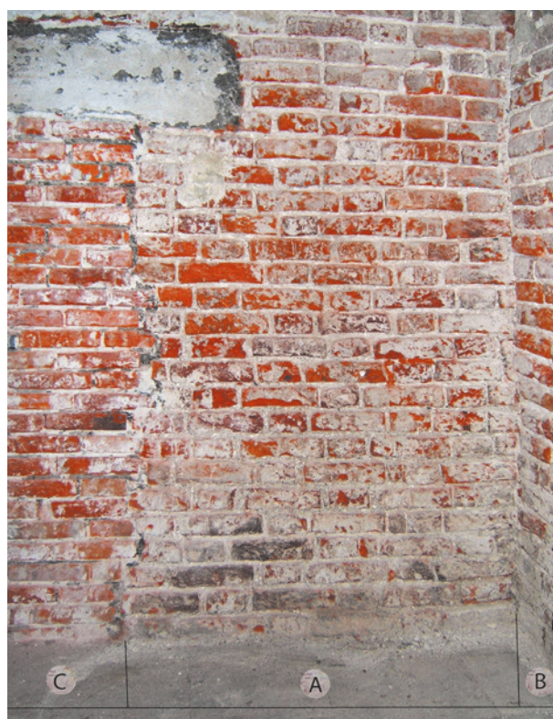
Ryc. 16. Wążek wschodniej ściany zakrystii (początek XVI w.) (A). Po prawej krawędź ściany południowej, niepowiązanej z nią murarsko (B). Po lewej fragment współczesnego zamurowania wtórnego otworu wejściowego zabezpieczonego u góry belką żelbetową (C); fot. I. Jakubczyk
