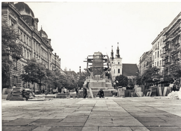
Plac Matejki, prace montażowe przy cokole pomnika, wrzesień 1976 r., aut.fot. nieznan; wł. MHK, nr inw. Fn 2370/IX
