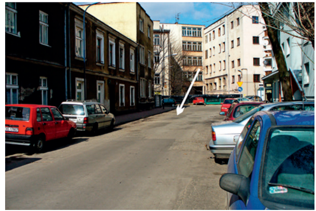
Właz kanałowy przy ul. Krakusa 25, fot. A. Pióro, 2008
