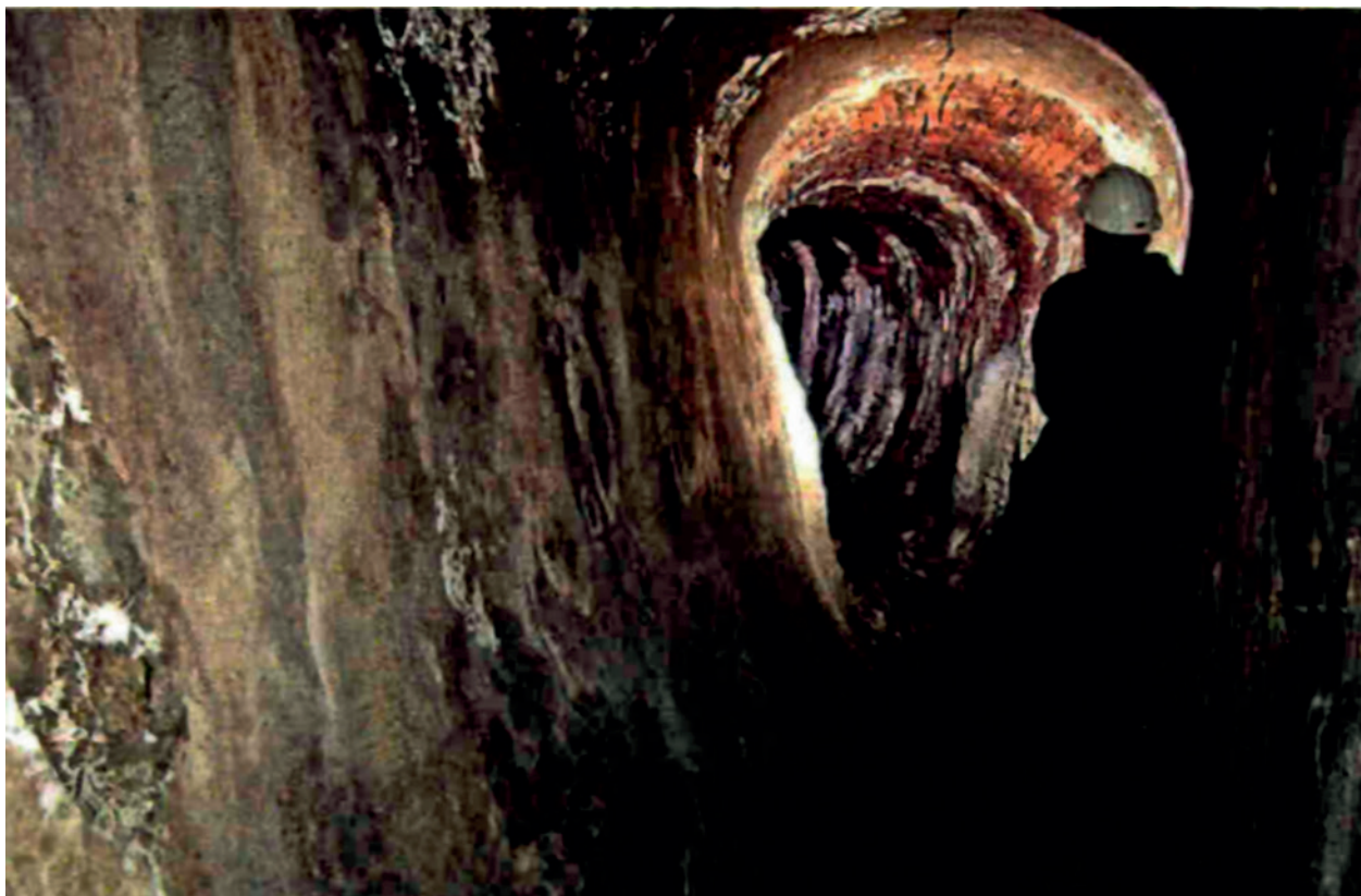
Wnętrze kanału pod ul. Targową, fot. MPWiK SA w Krakowie
