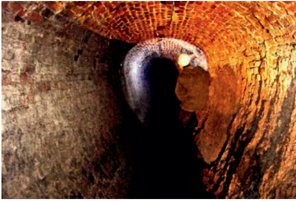
Wnętrze kanału pod ul. Krakusa, fot. MPWiK SA w Krakowie
