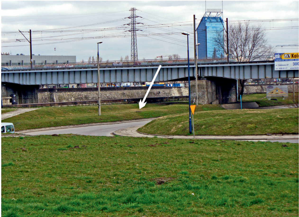
Właz kanałowy przy tzw. Trzecim Moście, fot. A. Pióro, 2008
