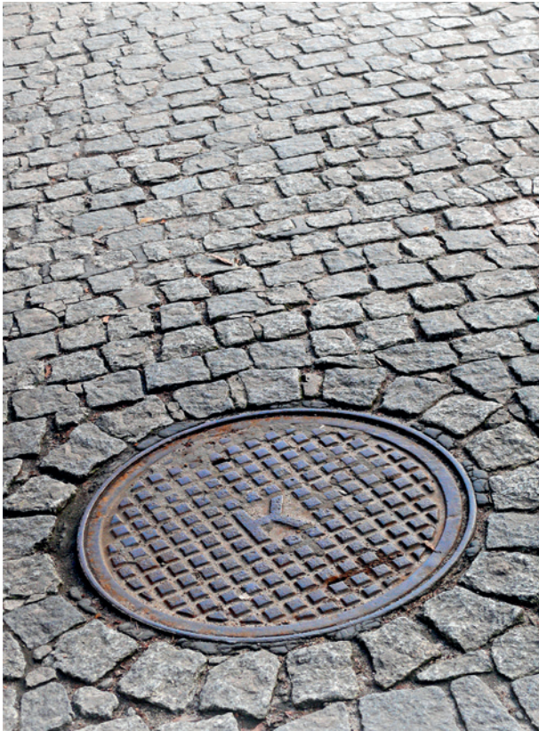
Wejście do kanału, fot. W. Sawicz, 2008
