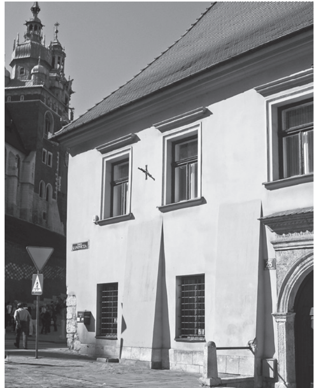
Dawny Okół, wtórne podwyższenie poziomu nawierzchni ul. Kanoniczej i ul. Podzamcze pod Wawelem w rejonie Domu Długosza, fot. B. Krasnowolski
