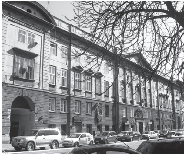
Stradom, budynek austriackiej komory celnej adaptujący kompleks klasztoru i szpitala bożogrobców, fot. B. Krasnowolski
