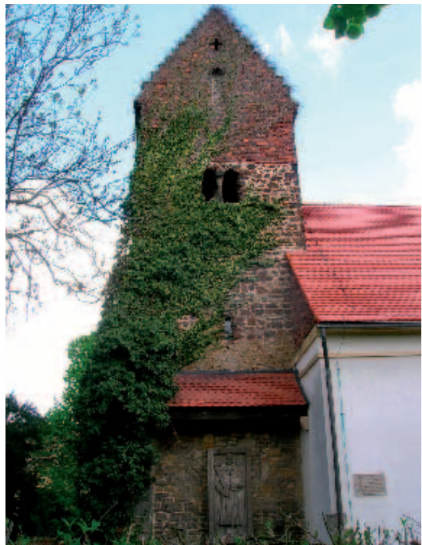
Romańska wieża kościoła w Reppichau (XIII wiek); fot. i wł. H. Lücka
