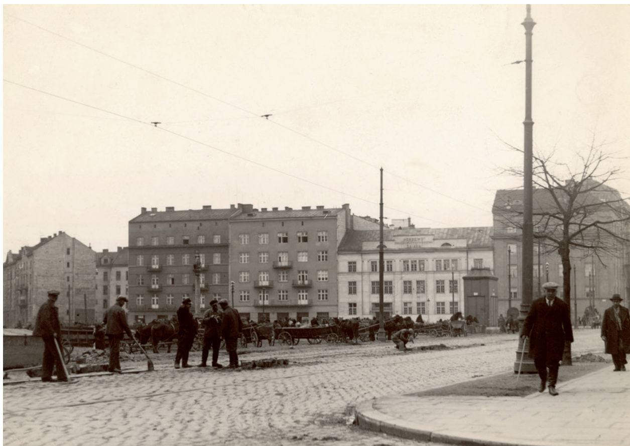
Widok na plac targowy u wylotu ul. Długiej, fot. Agencja Fotograficzna Światowid, 1934; w zbiorach MK, nr inw. MHK-Fs6861/IX
