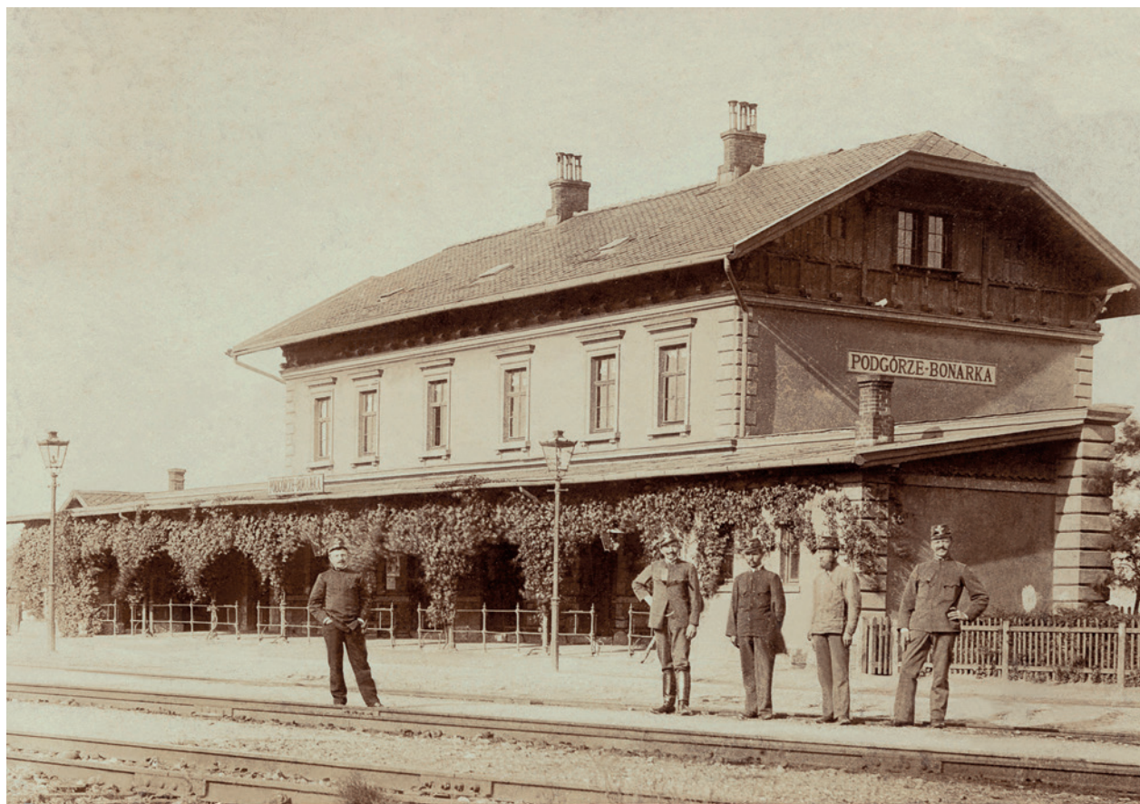
Budynek dworca na stacji Podgórze Bonarka, autor fotografii nieznanym, przełom XIX i XX w.; w zbiorach MK, nr inw. MHK-Fs220131/IX
