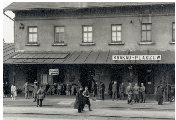
Wybudowany w latach 1883–1884 budynek dworca na stacji Kraków Płaszów widziany od strony torów, autor fotografii nieznan, 1939–1944; w zbiorach MK, nr inw. MHK-Fs22514/IX/188
