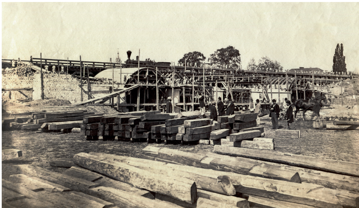
Budowa mostu Kolei Karola Ludwika przez Starą Wisłę (obecnie wiadukt Grzegorzeczki). Na drugim planie most drewniany z pociągiem roboczym prowadzonym parowozem serii IIIb, fot. Walery Rzewuski (?), 1862; w zbiorach MK, nr inw. MHK-Fs22099/IX
