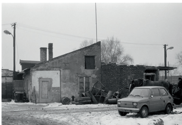
Ryc. 12. Rudera na składzie węgla przy ul. Zabłocie 6/8, fot. Henryk Świątek, styczeń 1981 r.; w zbiorach MHK, DAU Pg., nr 596
