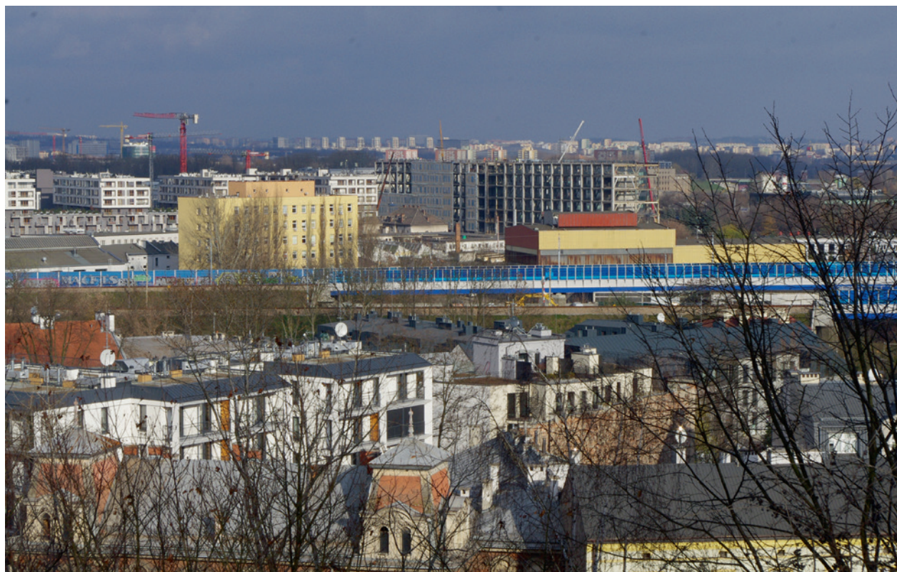
Ryc. 1. Widok z Krzemionek Podgórskich na zmieniające się Zabłocie, fot. Elżbieta Firlet, 28 listopada 2018 r.; w zbiorach MK, Dział Dokumentacji Architektury i Urbanistyki (dalej cyt. DAU) Podgórze (dalej cyt. Pg.), nr 4894
