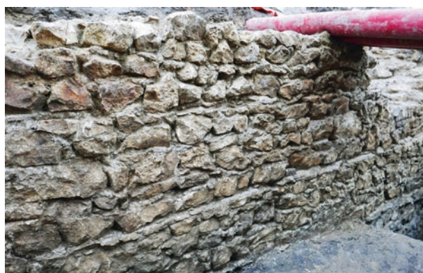
Wschodnie lico warstwowanego muru wykonanego z wapienia łamanego, biegnącego równoległe do pierzei ul. Krakowskiej w partii dawnej bramy Krakowskiej, fot. Marek J. Łukacz, 2019
