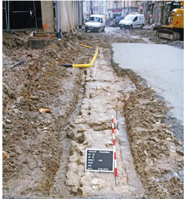
Odsłonięty pod nawierzchnią ulicy odcinek warstwowanego muru, równoległy do ściany elewacyjnej domów przy ul. Krakowskiej 5 i 7, widok ku północy, fot. Piotr Cora, 202
