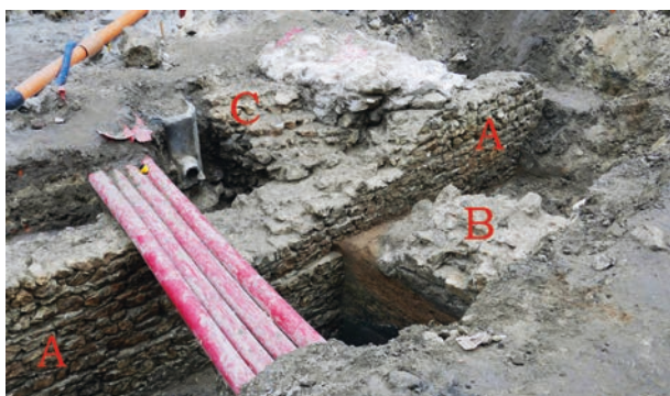
Odsłonięte w trakcie badań archeologicznych partie murów w rejonie dawnej bramy Krakowskiej: A – warstwowany mur równoległy do pierzei ulicy, B – relikwint ławy płytko posadowionego muru poprzecznego, C – część muru obronnego Kazimierza, widok ku północnemu wschodowi, fot. Marek J. Łukacz, 2019
