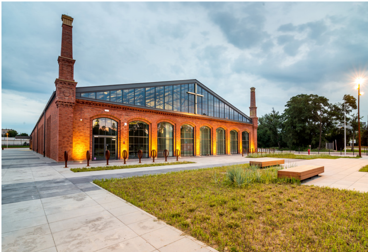
Budynek Centrum Historii Zajezdnia, fot. Marcin Jędrzejczak; w zbiorach Centrum Historii Zajezdnia
