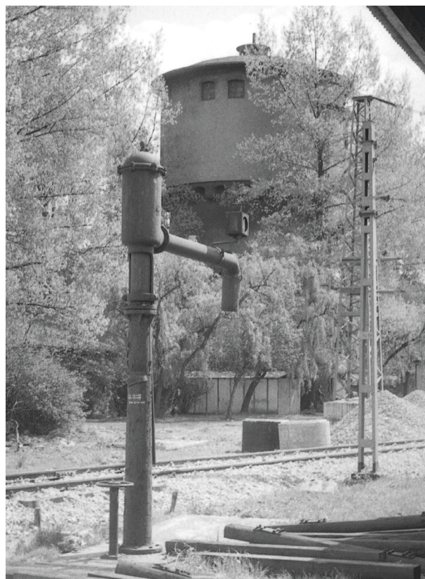
Zabytkowy, „wojenny” żuraw do wodowania parowozów firmy Krauswerk z Nowej Soli (Neusalz/Oder) przed złomowaniem. W tle zachowana do dziś wieża wodna; fot. Paweł Terczyński, 1984
