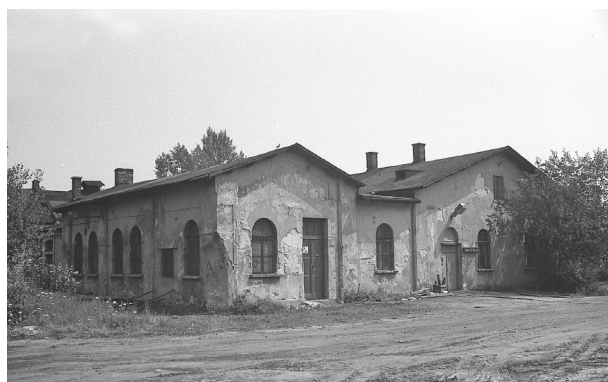
Zaniedbana zabudowa byłych warsztatów Kolei Północnej przed rozbiórką; fot. Krzysztof Słowikowski, 31 lipca 1984 r.
