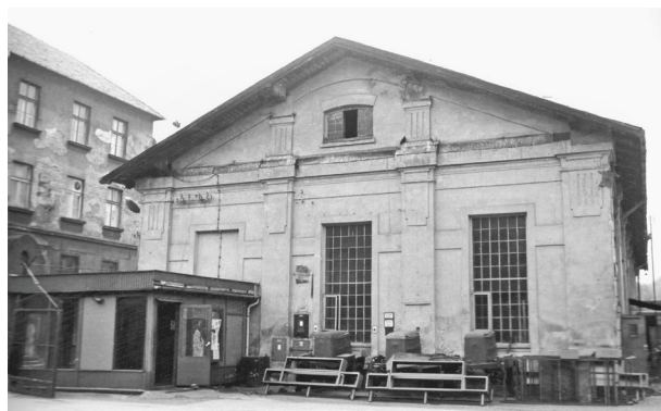
Elewacja wschodnia dawnych warsztatów c.k. Kolei Państwowych (kkStb) z 1897 r. W głębi z lewej strony międzywojenny budynek drukarni kolejowej. Stan z 1978 r.; autor fotografii nieznaną; w zbiorach Dominika Lulewicza
