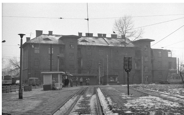
Rozbiórka domów przy ul. Bosackiej 26–28 związana ze wznowieniem budowy tunelu tramwajowego i peronów. Na pierwszym planie nieistniejąca pętla tramwajowa Dworzec Wschodni; fot. Paweł Terczyński, 1984
