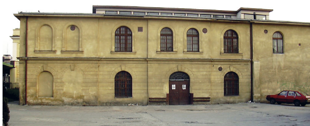
Północna elewacja poczty z lat 20. XX w. na rok przed rozbiórką; fot. Maciej Czapkiewicz, 24 kwietnia 2003 r.
