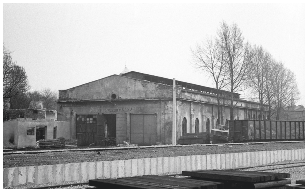
Zaniedbana dawna hala rozprzegania wagonów, późniejsza motowozownia w 1987 r. Zwracają uwagę półkolisto sklepione okna w elewacji bocznej oraz podłużny świetlik kalenicowy na dachu. Na fasadzie resztki napisu ostrzegawczego: „Przed wjazdem stój!”; fot. Paweł Terczyński, 1987
