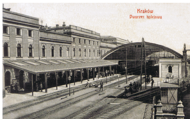
Widok dworca wraz z drugą halą peronową od strony torów. Z prawej strony typowy dla kolei austriackich ażurowy semafor kształtowy. U dołu przyczółek wiaduktu nad ul. Lubicz, 1909, pocztówka; w zbiorach Marka Ćwikły
