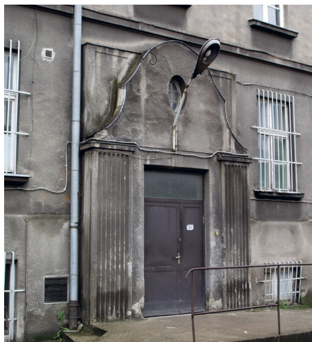
Ozdobny portal drukarni kolejowej, stan z maja 2010 r.; fot. Dominik Lulewicz
