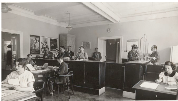
Biuro Polskiego Związku Turystycznego przy ul. Lubicz 4 w Krakowie (pałac Wołodkowiczów), 1937, fot. Agencja Fotograficzna „Światowid”. Na ścianach widoczne plakaty reklamujące Dni Krakowa; w zbiorach MHK, nr inw. MHK-16061/IX
