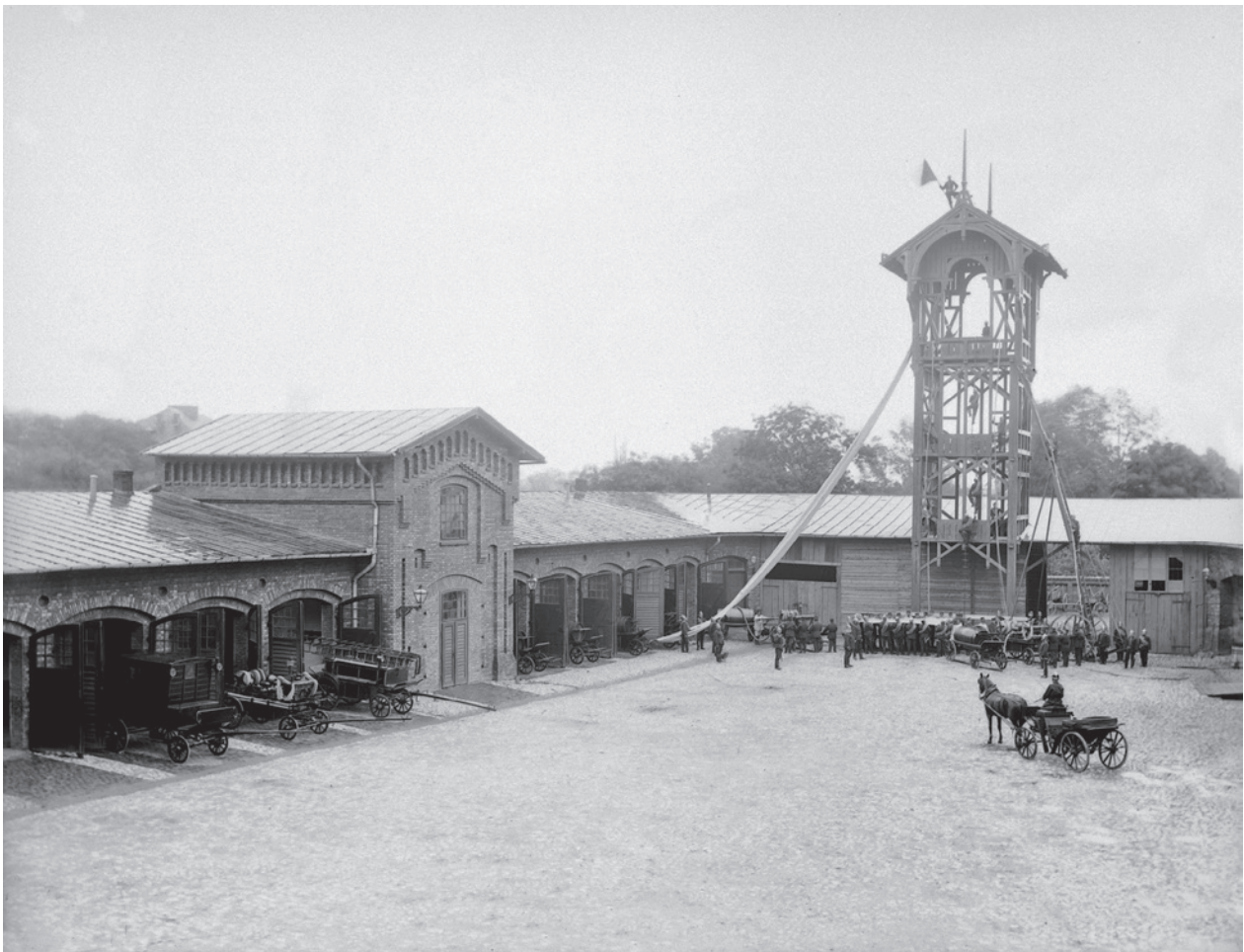
Wschodni narożnik dziedzińca koszar Miejskiej Straży Pożarnej przy ul. Kolejowej. Po prawej stronie widoczny jest budynek remizy na pojazdy pożarnicze. W jego podwyższonej części znajdowała się suszarnia węży gaśniczych. Po stronie prawej widoczna już zabudowana, drewniana wiata z górującą nad nią pierwszą, drewnianą wspinalnią; wł. MHK, nr inw. MHK 7892/K
