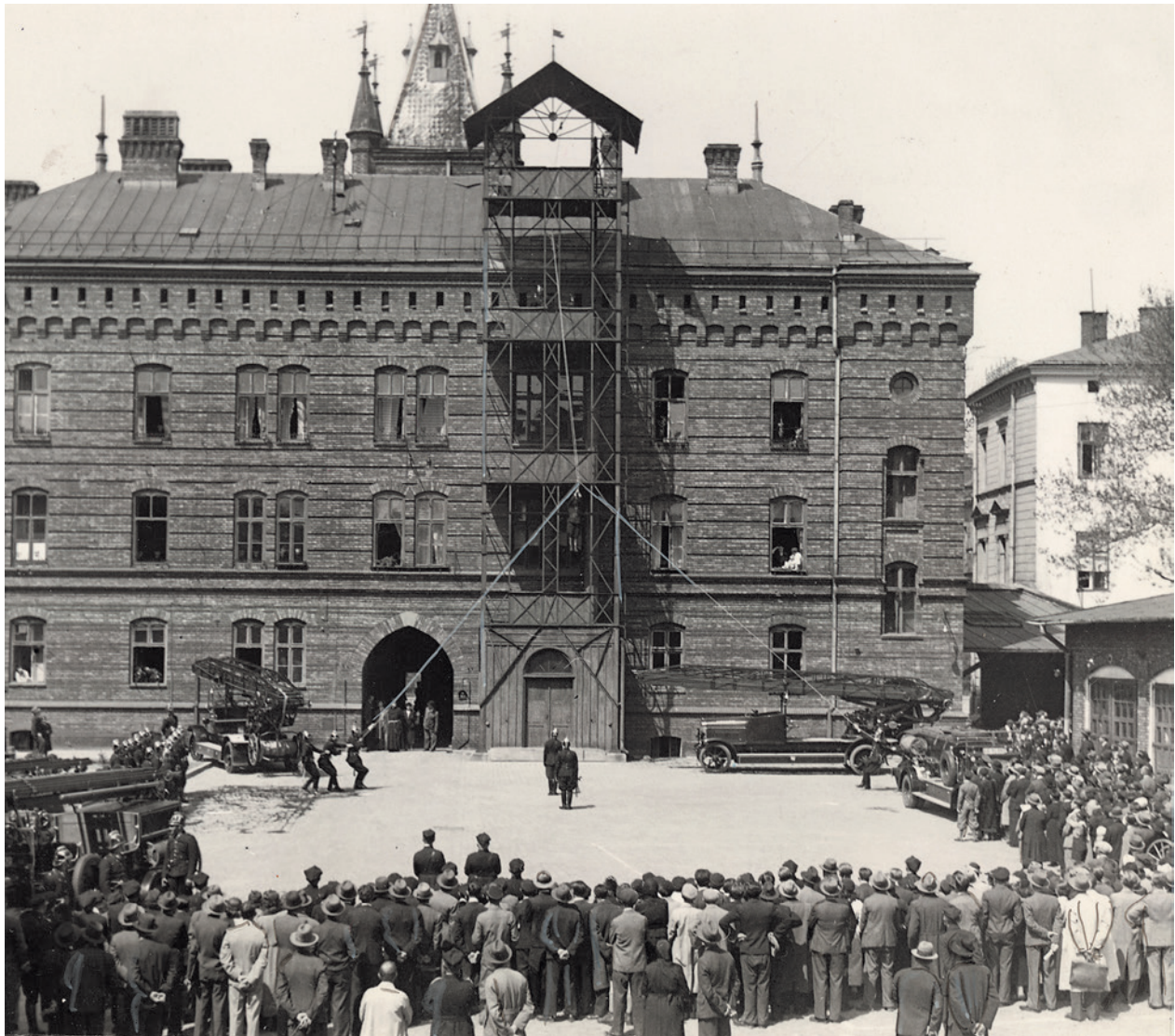
Ćwiczenia Miejskiej Straży Pożarnej na dziedzińcu strażnicy przy ul. Kolejowej, lata 30. Widoczna stalowa wspinalnica z 1905 r., zaprojektowana i wykonana przez krakowską „Fabrykę siatek, mebli, konstrukcji żelaznych i wyrobów ornamentalnych kutych Józefa Goreckiego”, fot. AF „Światowid”; wł. MHK, nr inv. Fs 7820-IX
