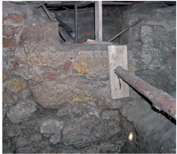
Ryc. 26. Przedproże północne, ściana wschodnia. Dolna część zachowanej kamieniarki okiennej w pierwszym oknie od strony północnej. Przy węgarach uzupełnienia z grubej, palcowanej cegły. Poniżej parapetu wążek kamienniej ściany przemurowany. Fazowane węgary i parapet wykonano z monolitycznego bloku wapienia, fot. L. Holcer
