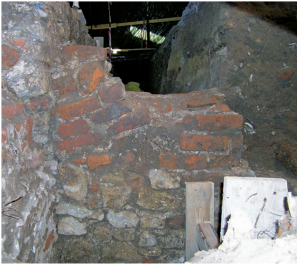
Ryc. 25. Przedproże północne, ściana wschodnia. Górny fragment północnego muru oporowego dostawionego do elewacyjnej ściany przedproża, przy dawnym zejściu z Rynku. Na koronie kamiennego muru pozostałości ukośnie biegnącego, ceglano sklepienia, fot. L. Holcer
