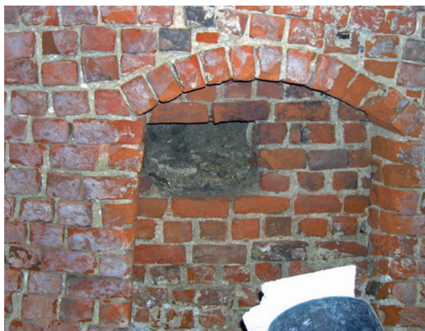
Ryc. 19. Południowo-wschodni fragment sklepienia w komorze północnej. Sposób opracowania lunety dawnego okna w kolebce ceglano-kamiennego sklepienia. Zamurówka otworu osadzona w ościeżu poprzez wkucie, wykonana z grubej, gotyckiej cegły palcowanej, pozyskanej z materiału rozbiórkowego, fot. Ł. Holcer
