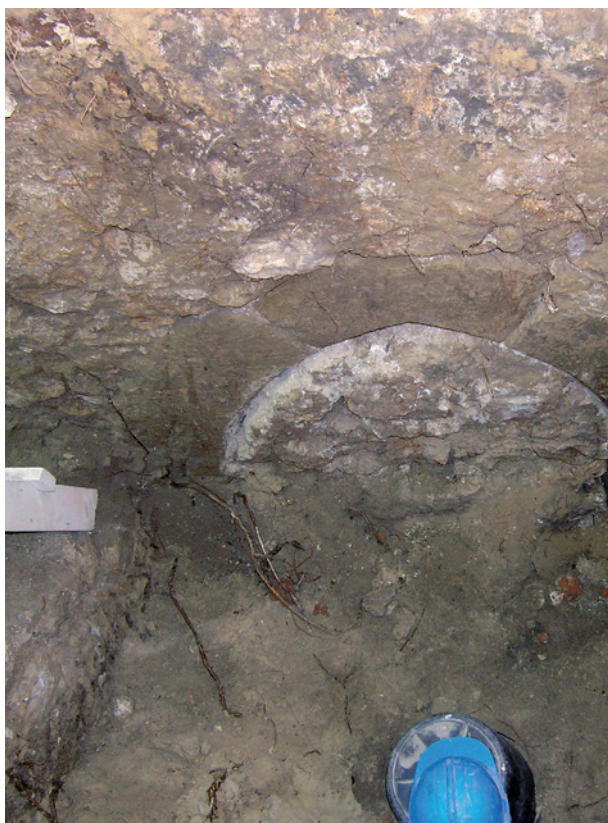
Ryc. 21. Przedproże południowe, ściana wschodnia (elewacyjna). Górna część ostrołucznego, fazowanego portalu z piaskowca. Po bokach korony kamiennych murów oporowych. Początkowy etap prac badawczych, fot. Ł. Holcer
