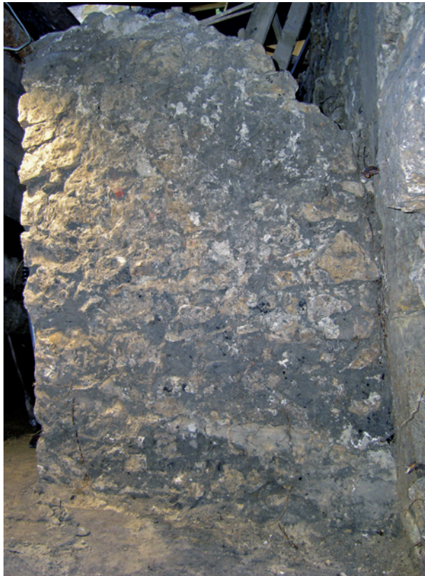
Ryc. 23. Przedproże południowe. Widok lewego czyli południowego muru oporowego, dostawionego do czołowej ściany przedproża. Z prawej fragment kamieniarki portalu, fot. Ł. Holcer
