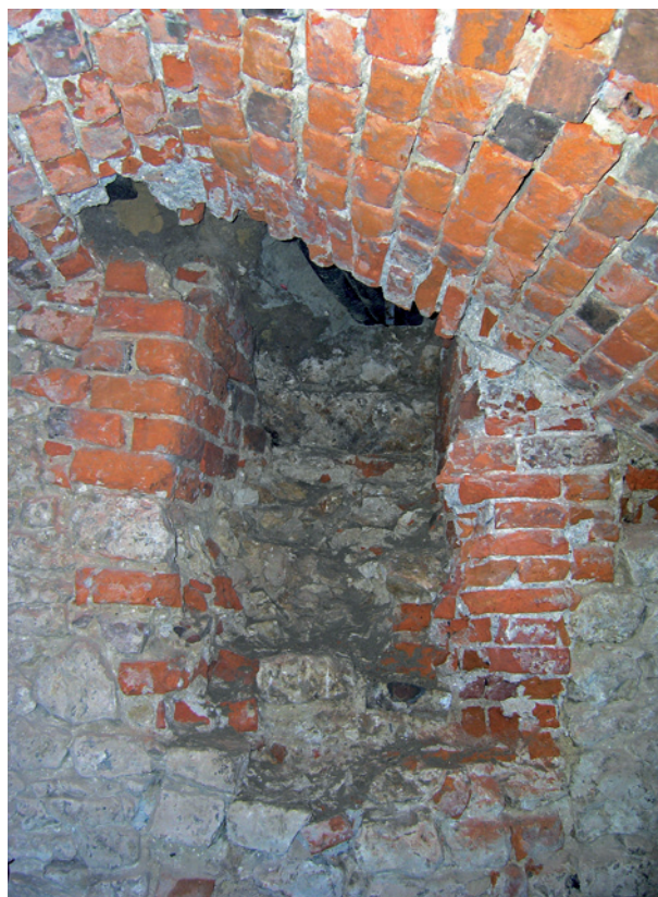
Ryc. 20. Fragment północnej ściany przedproża. Ceglano-kamienne glify w otworze dawnego okna od strony ul. Sławkowskiej. Prawe ościeże wtórnie zawężone. Stan po usunięciu zamurówki, fot. Ł. Holcer
