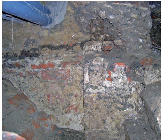
Ryc. 28. Przedproże południowe, ściana wschodnia. Północne ościeże dawnego okna (drugie od strony południowej). Na ścianie lunety ustawionej w pasze sklepienia, zachowane fragmenty cienkiego tynku gotyckiego (z lewej). Z prawej fragment zachowanej, dolnej części kamieniarki okiennej, ukośnie osadzonej w stosunku do lica ściany, fot. L. Holcer
