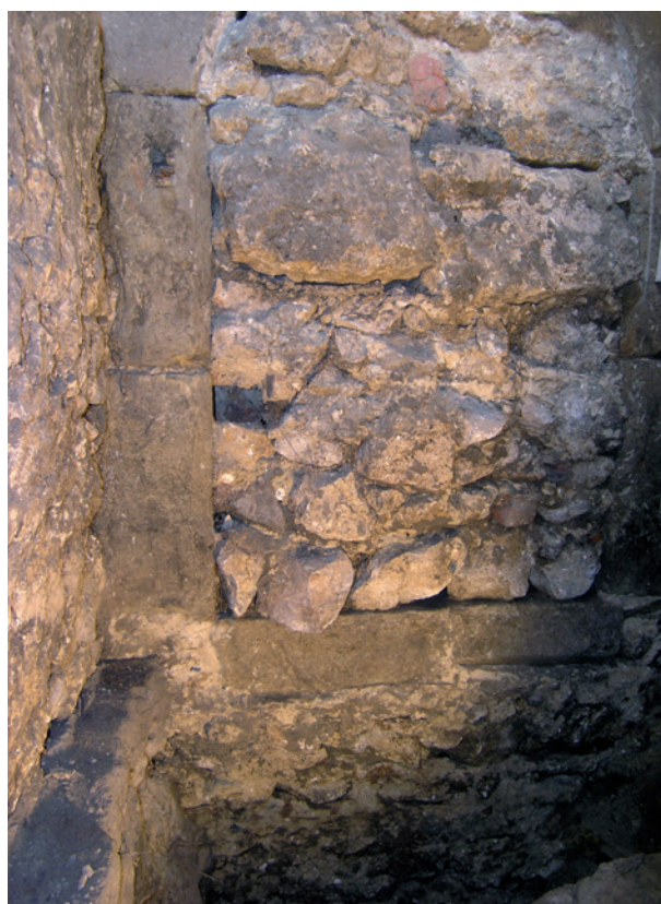
Ryc. 22. Przedproże południowe, ściana wschodnia (elewacyjna). Zamurowany portal w otworze dawnego zejścia z Rynku do komory przedproża. Z lewej fragment kamiennego muru oporowego, fot. Ł. Holcer
