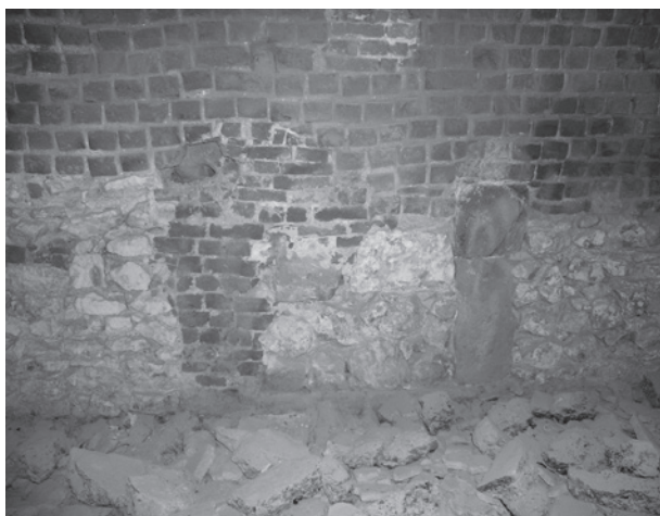
Ryc. 17. Zamurowany kamieniem łamanym otwór przejścia w elewacji dawnego budynku południowego. Zachowany węgar i próg wykonano z piaskowca. W miejscu drugiego węgara zamurówka z cegły palcowanej, cieńszej niż w sklepieniu. Kamieniarka osadzona in situ w wątku muru, fot. Ł. Holcer
