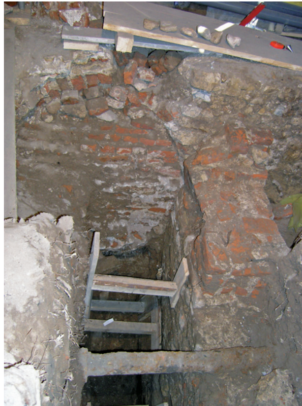
Ryc. 24. Przedproże północne, ściana wschodnia. Zamurowany otwór przejścia z Rynku do komory północnej. Po prawej kamienny mur oporowy z fragmentem ceglanej kolebki po dawnym sklepieniu, fot. Ł. Holcer
