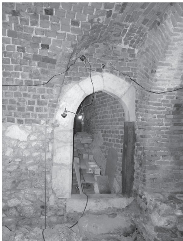
Ryc. 18. Fragment wschodniej elewacji dawnego budynku północnego (narożnego). W przejściu do najniższej kondygnacji domu wtórnie osadzony portal z wapienia pińczowskiego. Prawy węgar wykonany z piaskowca. Poniżej progu kamienny stopień o nieregularnej formie (głaz wapiennej). Z prawej przysięcnienny filar i gurt wspierający kolebkę sklepienia – elementy wzniesione z cienkiej cegły palcowanej, fot. Ł. Holcer
