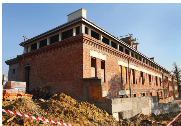
Prace terenowe od strony windy towarowej – wyrównywanie terenu pod parking i garaż, 2012, fot. Andrzej Janikowski
