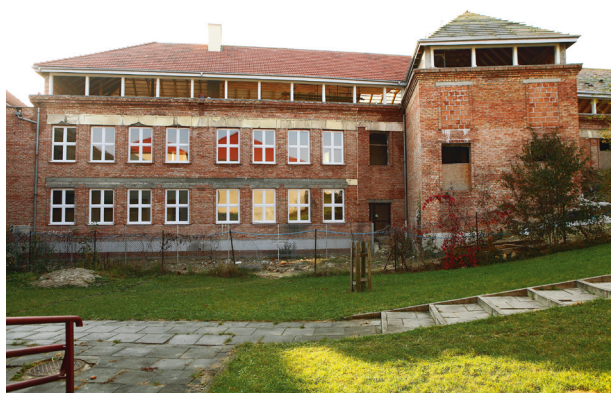
Wygląd budynku po wmontowaniu okien i położeniu dachówki, 2012, fot. Andrzej Janikowski
