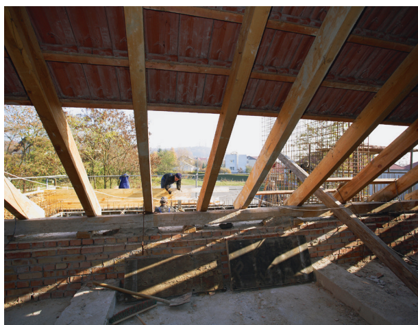
Budynek w trakcie podnoszenia dachu, 2011, fot. Andrzej Janikowski
