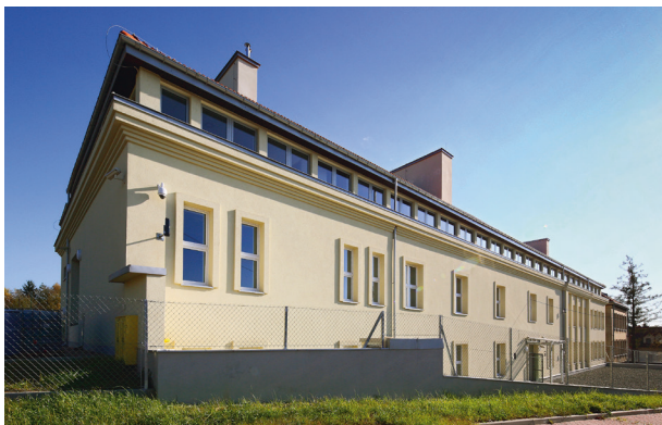
Widok budynku w trakcie prac przy górnej kondygnacji, 2012, fot. Andrzej Janikowski
