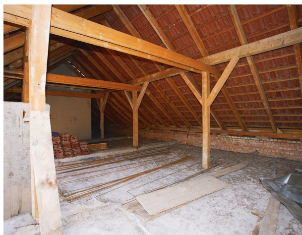
Budynek w trakcie prac podnoszenia więźby dachowej, 2011, fot. Andrzej Janikowski
