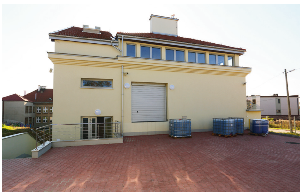
Budynek przygotowany do odbioru jesienią 2014 r., fot. Andrzej Janikowski
