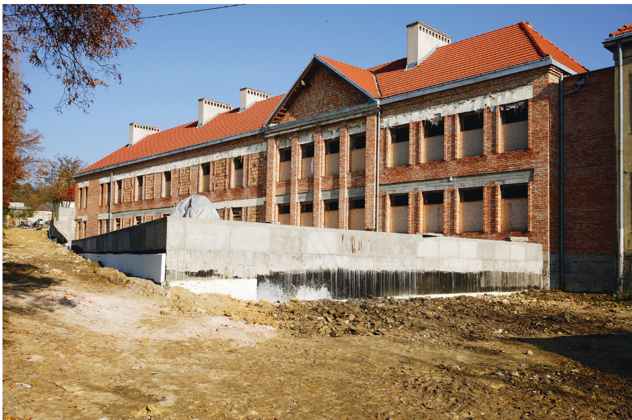
Budynek w trakcie przebudowy, 2011, fot. Andrzej Janikowski
