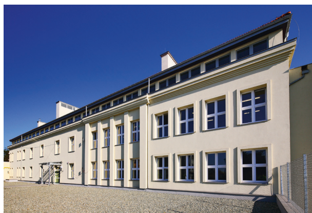
Widok budynku w trakcie prac przy górnej kondygnacji, 2012, fot. Andrzej Janikowski
