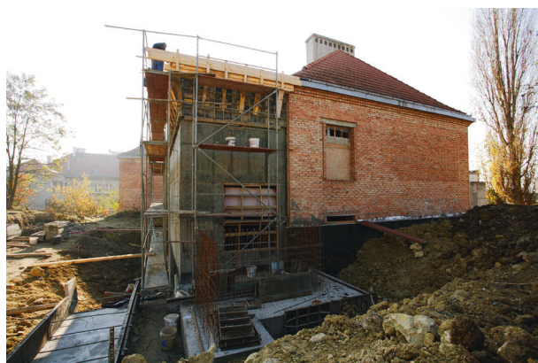
Budowa szybu windy towarowej od strony garażu, 2011, fot. Andrzej Janikowski
