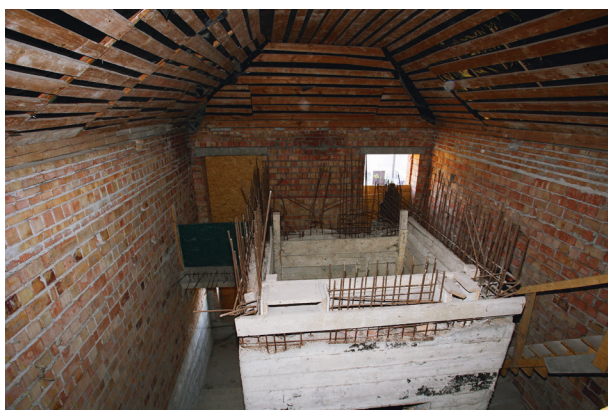
Budowa szybu windy towarowej, 2011, fot. Andrzej Janikowski
