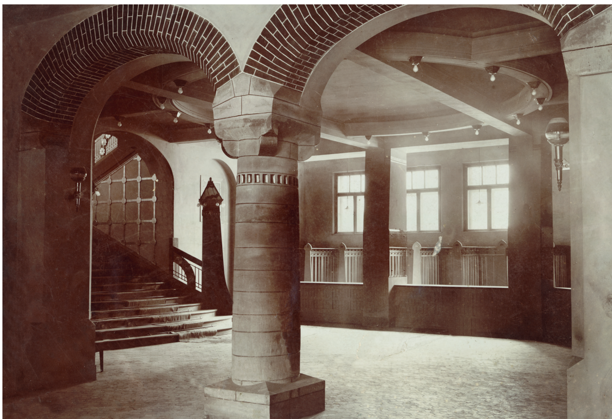
Stary Teatr – westybul, szatnie i schody główne, 1907, fot. Tadeusz Jabłoński; w zbiorach MHK, nr inw. MHK-Fs896/IX
