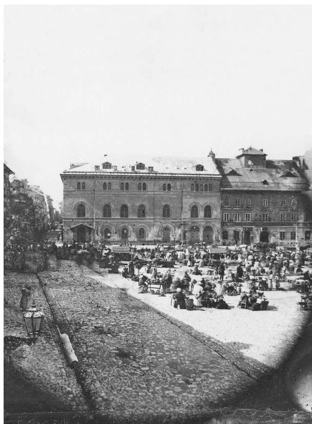
Stary Teatr i kamienica pod nr. 2 przed przebudową, 1865–1870, fot. Ignacy Krieger; w zbiorach MHK, nr inw. MHK-5398/K
