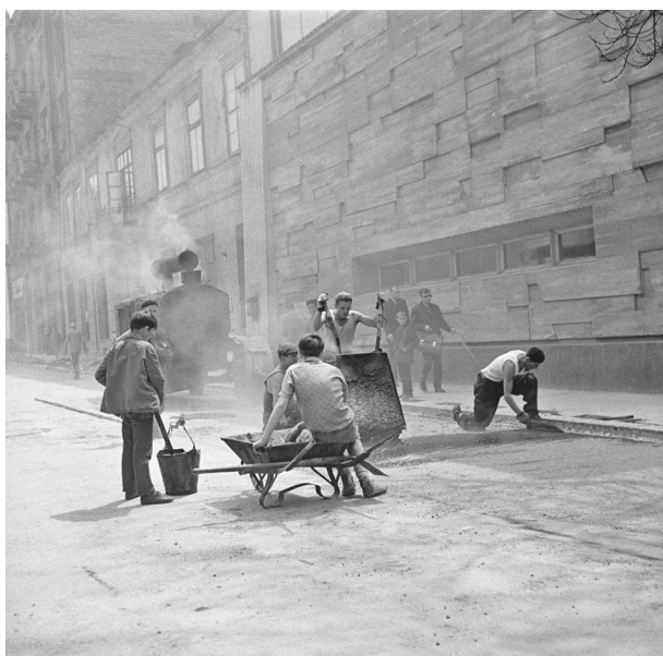
Robotnicy wylewający asfalt na jezdnię w narożniku przy Plantach, na wysokości Biura Wystaw Artystycznych, 1965–1966, fot. Henryk Hermanowicz; w zbiorach MHK, nr inw. MHK-1327/N/3
