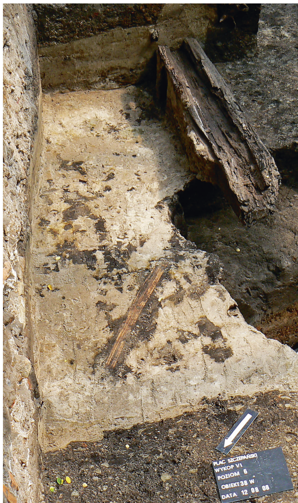
Ryc. 35. Budynek – obiekt 38, fragment belki podwalinowej
